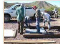
Assembling the kiosk.
