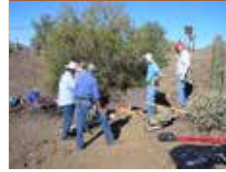
Ready to pour the pre-mix.
