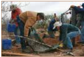
Mix the concrete.
